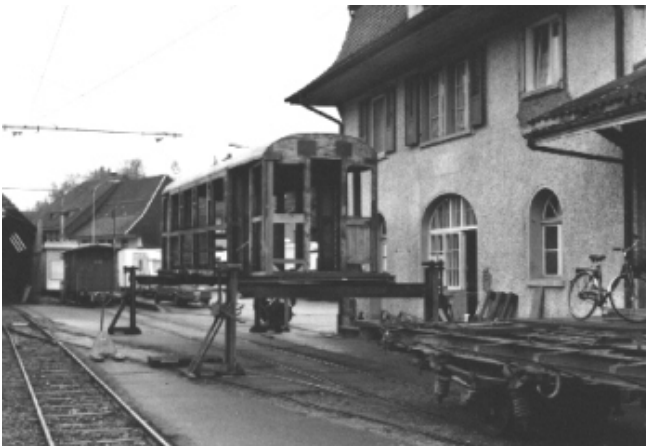
Der Kasten des "Melchnauerli" steht bereit um auf den Strassenanhänger verladen zu werden. Am rechten Bildrand ist das Untergestell erkennbar (Foto: © FSS; Reto Steiner).
